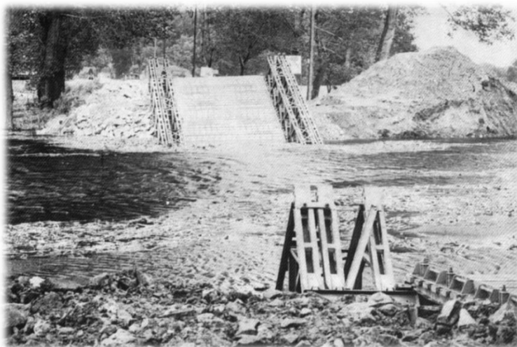
Slika 3. Fotografija miniranog mosta – izvor: arhiva Hrvatskih voda Figure 3. Photo of a mined bridge – source: Hrvatske vode archive
