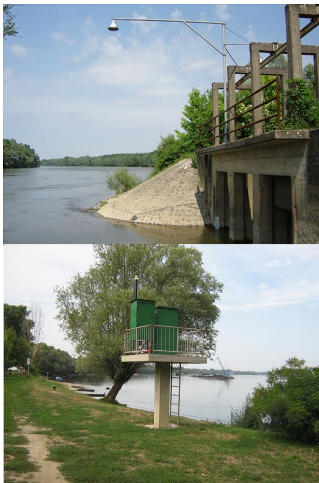
Slika 2. Ugradnja vodomjera na elemente crpne stanice (D. Miholjac) i kao samostalnog objekta (Aljmaš)
